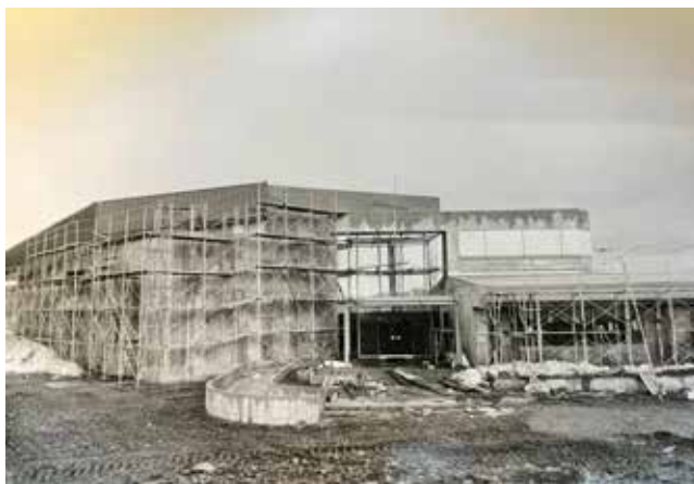
建設中の東川町農村環境改善センター＝1978年(昭和53年)ごろ
