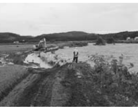
倉沼川左岸の護岸決壊と水田冠水現場(23日午前9時ごろ、西8号行楽橋から下流約200メートル左岸付近)
