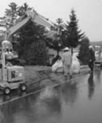
決壊寸前の倉沼川沿いで作業を急いでいる住宅周辺の土のう積み(21日午後6時、西10号北41の杉本宅付近(豊年橋付近から))
