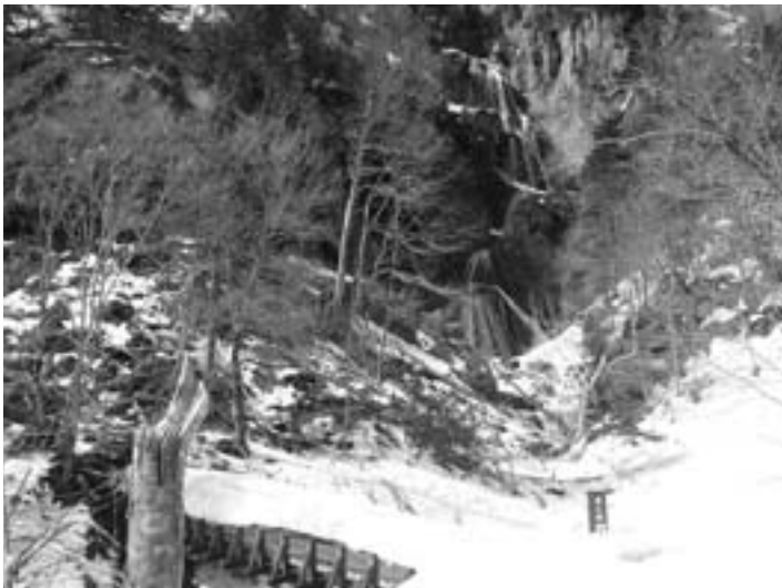
羽衣の滝(正面右)の左側が土砂崩れました(直下の橋も土砂に埋まっています) =5月10日撮影
