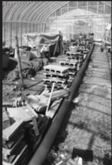
ビニルハウスの中で製作中の炭焼きがま(長さ10メートル以上)
