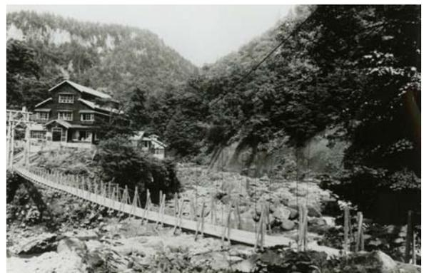
昭和 28 年頃の天人閣本館。切妻破風はふや窓枠を白、板壁をセピア色に塗装した。吊り橋の欄干は垂木たるきと 8 番鉄線で出来ていたので上下左右に揺れた
